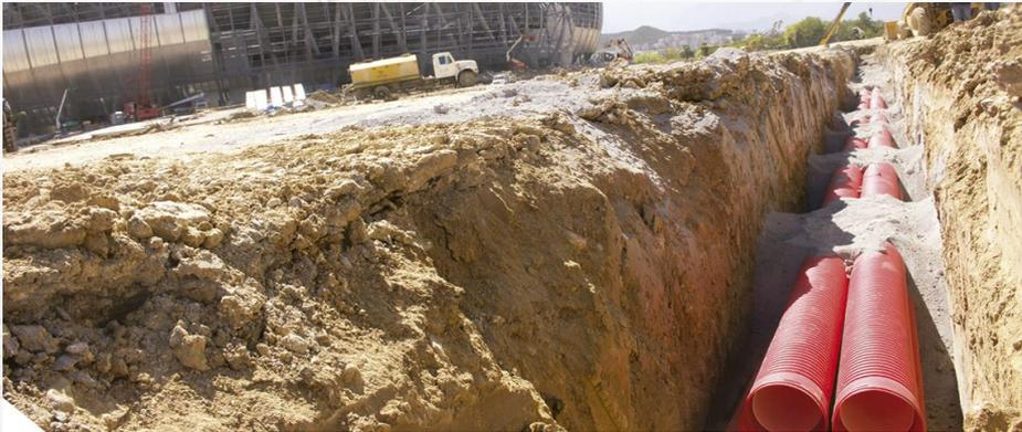
Tubería de Polietileno de Alta Densidad, de doble pared DW, con perfil corrugado exterior anular y un interior liso. Gracias a sus grandes beneficios lo podemos traducir en una instalación más rápida y eficiente, por lo tanto, un ahorro considerable en el costo final del proyecto.
