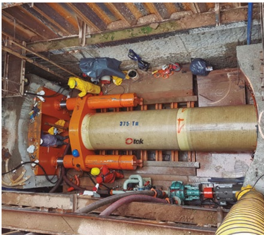
Pipe Jacking de tuberías Flowtite
