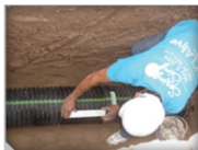
Figura 13. Verificación de posición de empaques con lana plástica por el interior y exterior.
