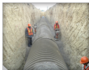
Figura 16. Colocación y compactación simétrica por capas.
