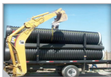
Figura 2. Descarga con maquinaria de 24 a 60 pulgadas.
