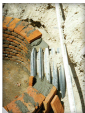
Figura 20. Conexión a pozo con empaques de valle.
