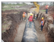
Figura 16. Colocación y compactación simétrica por capas.
