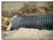
Figura 12. Empuje con maquinaria.
