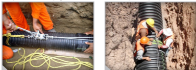
Figura 11. Inserción de espiga en campana con el uso de polipastos (conocidos como tecles o tirlor).
