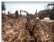
Figura 16. Colocación y compactación simétrica por capas.
