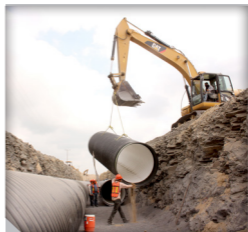
Figura 9. Bajado con maquinaria de tubería a la zanja, usar dos puntos de sujeción.
