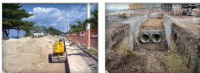
Figura 19. Compactación relleno final.
