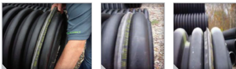
Figura 21. Colocación de empaques de valle.
