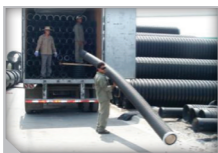
Figura 1. Descarga manual de tubería hasta 18 pulgadas.
