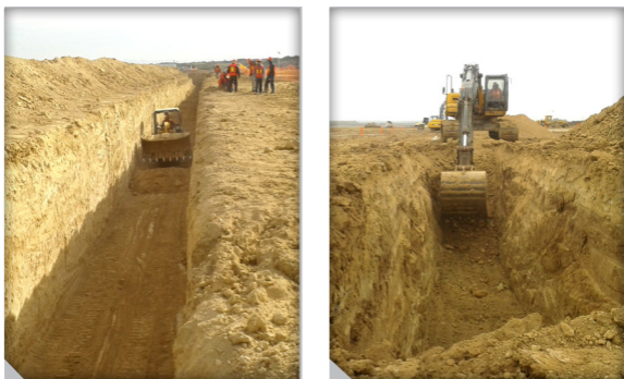
Figura 5. Excavación de la zanja.
