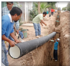
Figura 8. Bajado manual de tubería a la zanja.
