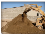
Figura 15. Humedad óptima al material de acostillado.
