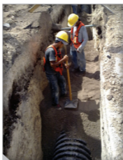
Figura 18. Compactación de relleno inicial.
