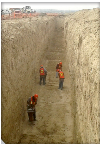
Figura 7. Compactación de encamado con equipo portátil.
