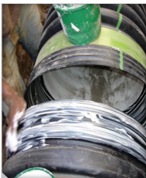
Figura 14. Colocación de lubricante.
