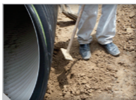
Figura 17. Herramientas para trabajos de acostillado.
